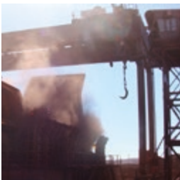
Kransteuerung Anspruchsvolle Anwendungen in den Minen Südafrikas
