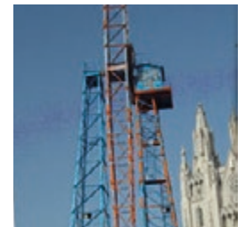
Parkhäuser Zuverlässige Steuerung schwieriger Lasten in Spanien
